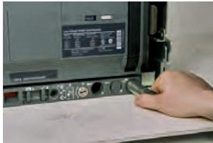
Racking Handle Storage Location - Einfahrkurbel Lagerungsart - Alloggiamento maniglia di manovra
