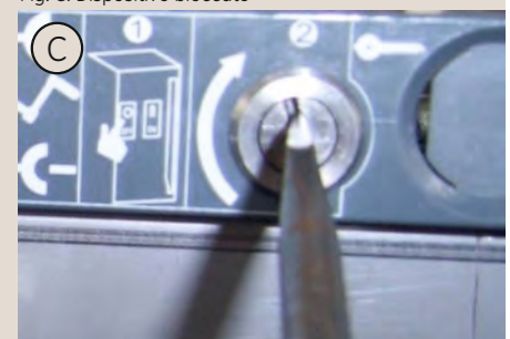
Fig. A: Premere il pulsante di spegnimento sull'interruttore Fig. B: Ruotare la chiave in senso antiorario Fig. C: Dispositivo bloccato
