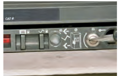
Racking Handle Shutter drive location - Verstellsschraube für Schutzkappenantrieb - Posizione della vite dell'otturatore del meccanismo di manovra
