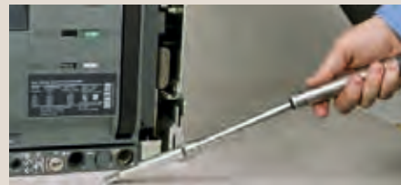
Fig. 1.10: Racking Handle use Abb. 1.10: Einfahrkurbel Verwendung Fig. 1.10: Uso della maniglia di manovra
