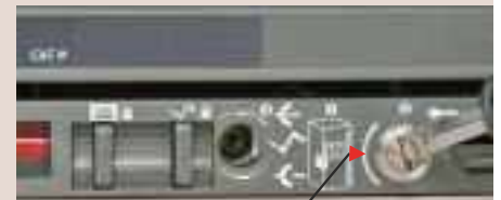
Fig. 1.11: Racking Screw Location A) Racking Shutter screw location B) Racking position indication -- Abb. 1.11: Lage der Schraube am Einschubträger A) Schutzkappenantrieb-Verstellungsschraube B) Einschubträger Stellungsanzeige -- Fig. 1.11: Posizione vite di manovra A) Vite otturatore meccanismo di manovra B) Indicazione della posizione di manovra
