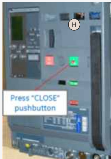
Abb. F: Zeigt den Versuch, die Handkurbelblende zu öffnen. Abb. G: Blockierter Sicherheitsriegel. Abb. H: Den "CLOSE"-Einschaltkaster betätigen um den Schalter einzuschalten (ON|EIN). Abb. I: "OFF"-Ausschaltkaster betätigen und den Schlüssel entnehmen.
