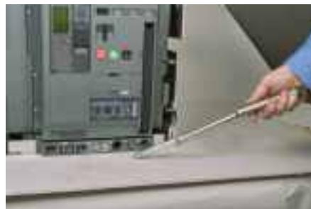
Racking Handle Extended - Einfahrkurbel auseinander gezogen - Maniglia di manovra estesa
