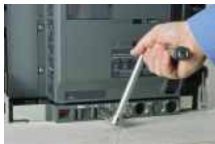
Racking Handle, engaged and in operation. - Einfahrkurbel eingesteckt im Verstellloch - Maniglia di manovra inserita nel meccanismo e in funzione.
