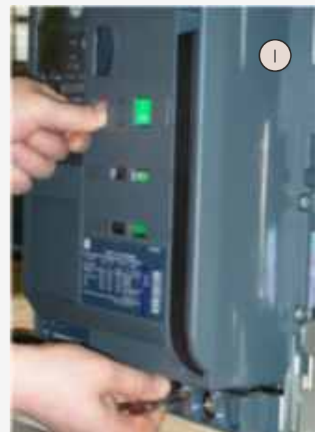
Fig. F: Tentativo di aprire l'otturatore del meccanismo di manovra. Fig. G: Barra di bloccaggio di sicurezza. Fig. H: Il pulsante per commutare l'interruttore in ON. Fig. I: Premendo "OFF" e rimuovendo la chiave.
