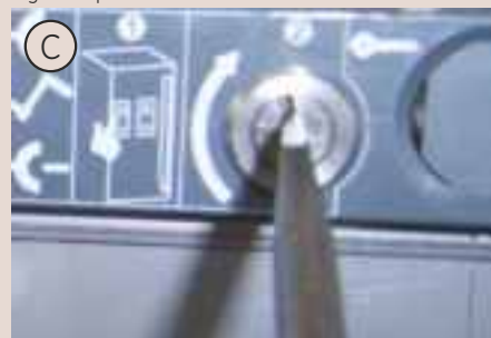
Fig. A: Premere il pulsante di spegnimento sull'interruttore Fig. B: Ruotare la chiave in senso antiorario Fig. C: Dispositivo bloccato
