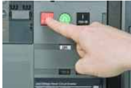
Turning device OFF - Schalter ausschalten - Portare il dispositivo in OFF
