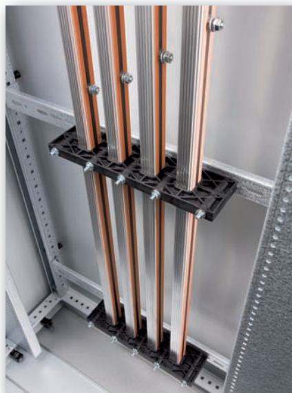
Montaggio vano cavi
