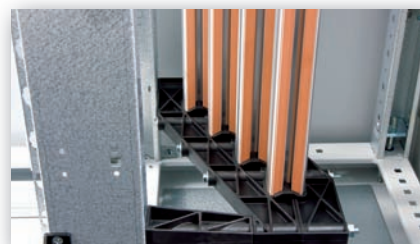
Montaggio vano cavi L=400mm
