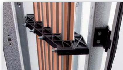
Montaggio vano cavi L=300mm
